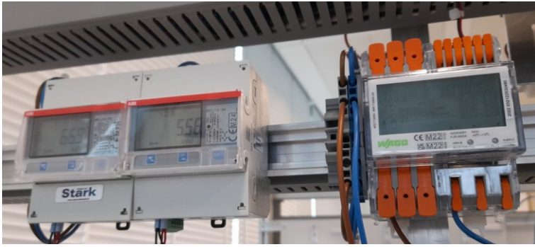
Abbildung 90: 3-Phasen-Stromzähler geeicht, direktmessend, Stark Elektronik (Einbindung über Modbus RTU):
