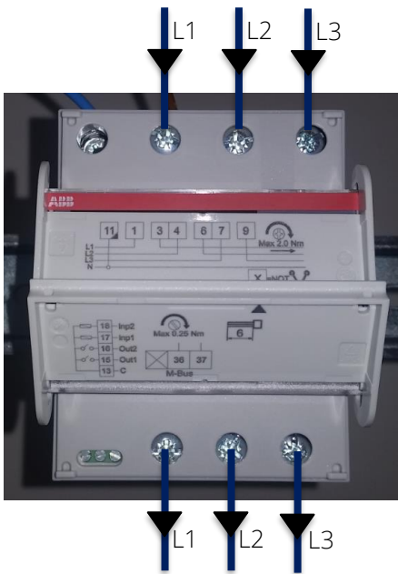
Abb. 8: Anschluss der drei Phasen L1, L2, L3 zur Messung eines Verbrauchers
