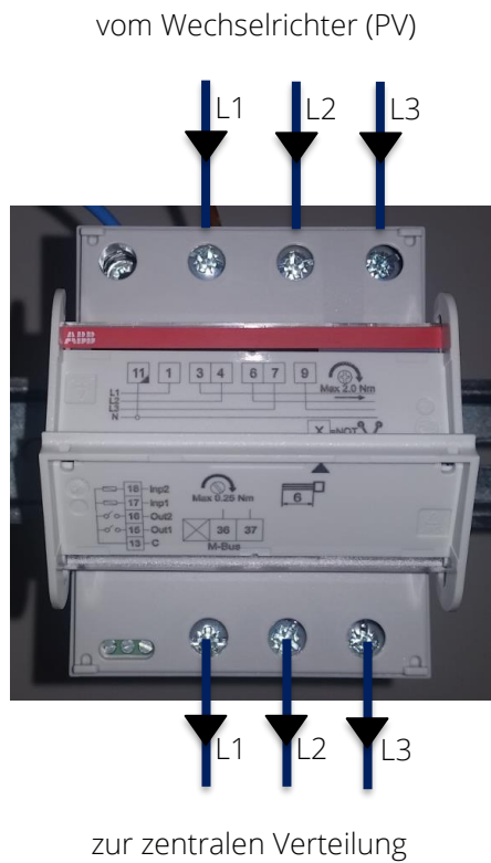
Abb. 7: Anschluss der drei Phasen L1, L2, L3 zur Messung der Produktion
