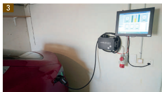
Installation bei einem Kunden mit Tesla Model S, Batteriekapazität 85 kWh, Ladeleistung variabel 4..11 kW.
